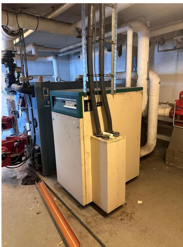
Figur 2: Eksisterende elkjel fra befaring 19.02.25
